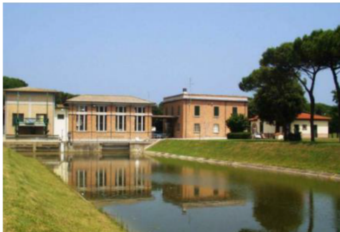
L'impianto di via del Remo a Punta Marina
